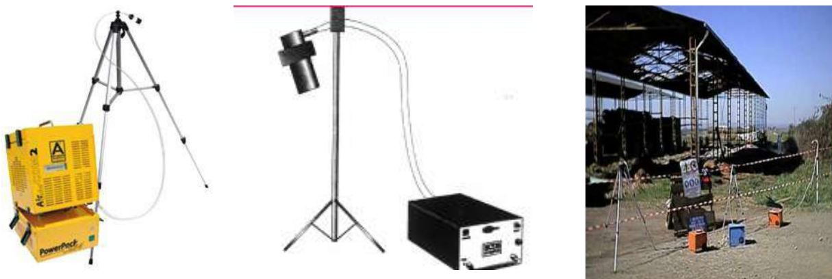
Figura 2: Esempio di installazione centralina di campionamento ambientale
