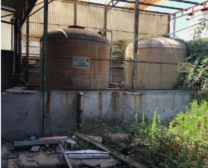
Figura 27: Serbatoi Acido cloridrico e Soda caustica
