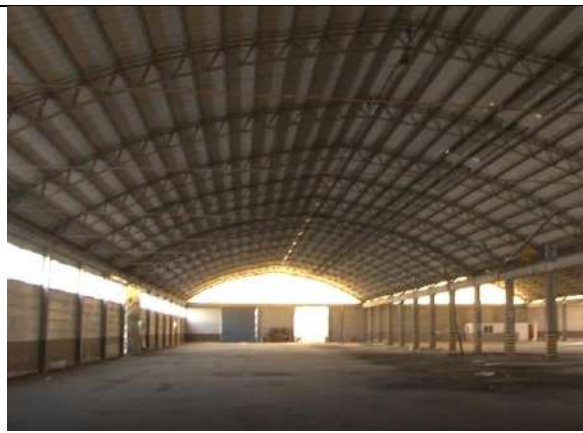
Figura 18: Copertura a volta con presenza di onduline in cemento amianto e pavimentazione industriale
