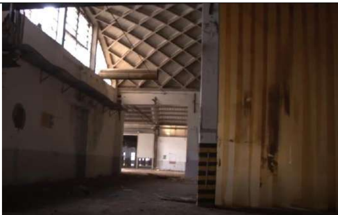
Figura 17: Copertura a volta con presenza di lastre piane in cemento amianto e pavimentazione industriale
