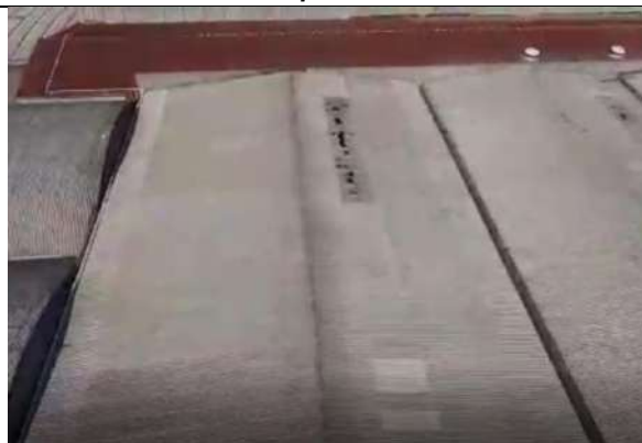
Figura 20: Particolare di copertura ad onduline in cemento amianto danneggiata (esterno Capannone Reparto ricevimento, alimentazione, cernita, ripreso da volo con drone)
