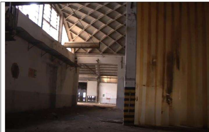
Figura 13: Copertura a volta con presenza di lastre piane in cemento amianto e pavimentazione industriale
