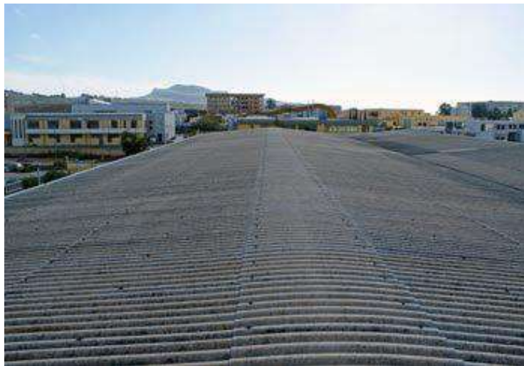
Figura 31: PRE-OPERAM (COPERTURA IN CEMENTO AMIANTO)
