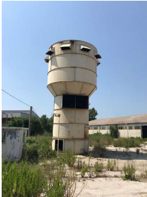
Figura 29: Filtro a torre metallica
