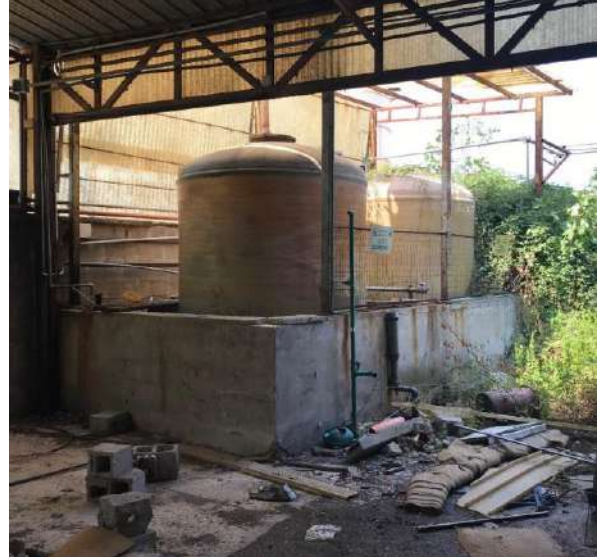
Figura 27: Serbatoi Acido cloridrico e Soda caustica
